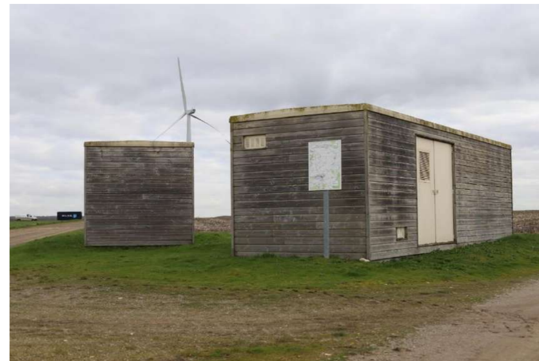
Photo 185 : Exemple de postes de livraison recouverts d'un bardage bois
